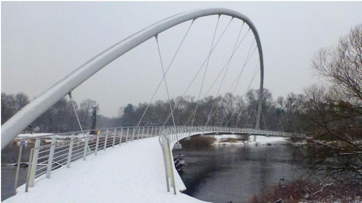
Eingriff in den Flusslauf zu vermeiden, wurde auf eine Lösung mit Brückenpfeilern verzichtet. Über dem Stahlkasten-Hohlträger befindet sich ein Stahlrohrbogen in einer geneigten Ebene, von dem der Wegträger mit Rundstahlstäben abgehängt ist und gleichzeitig den Bogen stabilisiert.
